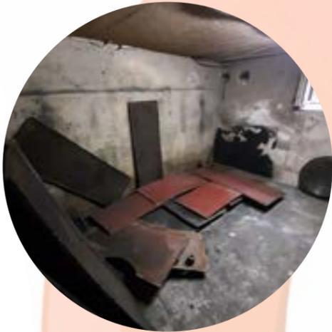
**6. Zerschneiden von Stahl- oder Entfernung von Kunststofftanks**
