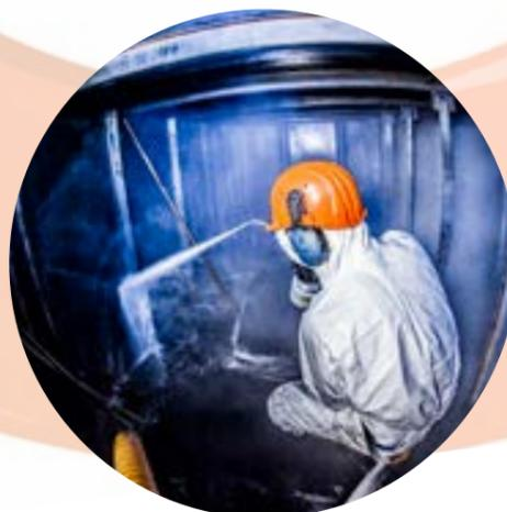
**4. Entlüftung, Einstieg, Reinigung und Entfettung des Öltanks**
